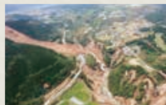
山腹崩壊(南阿蘇村立野)
