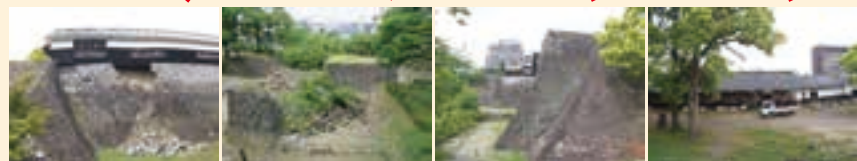
①数寄屋丸二階御広間 ②連続外枳形と石垣 ③二様の石垣 ④重要文化財櫓群
