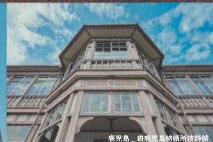
鹿児島 旧鹿児島紡績所技師館
