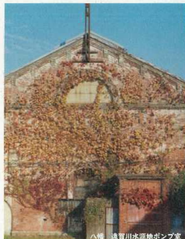
八幡 遠賀川水源地ポンプ室
