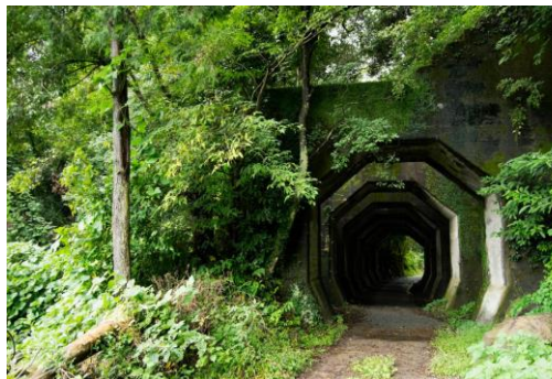
八角トンネル・熊延鉄道跡
